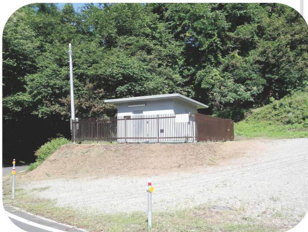
簡易水道 小菅送水ポンプ室
