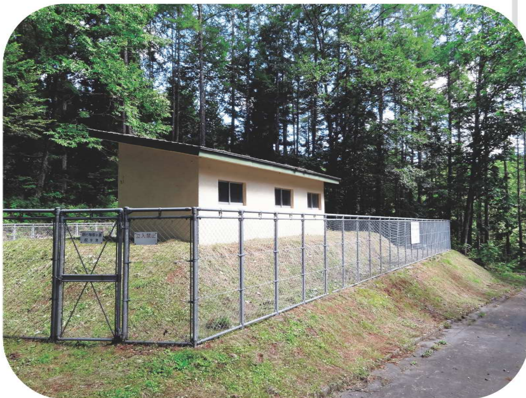
簡易水道 新行配水池
