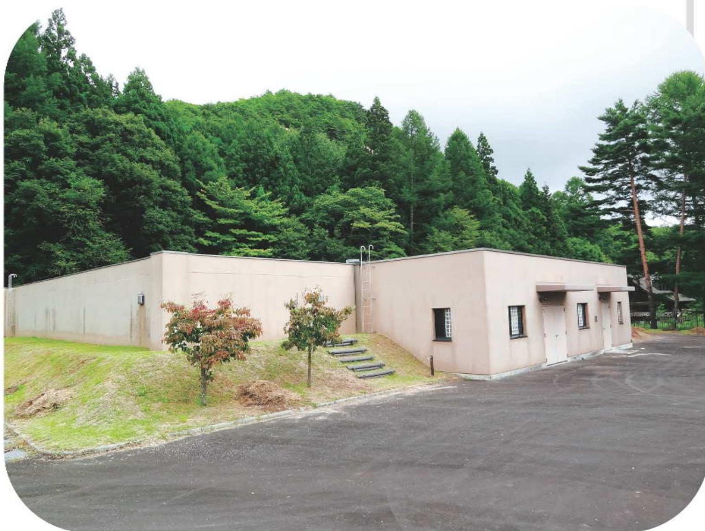
上水道 第3配水池
