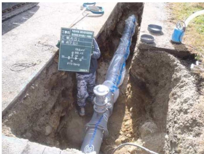
耐震管（ダクタイル鋳鉄管 DCIP-GX 形）
