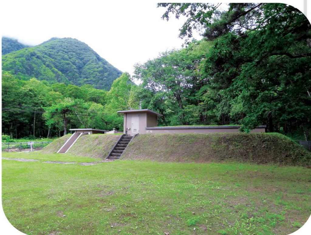
上水道 白沢低区配水池
