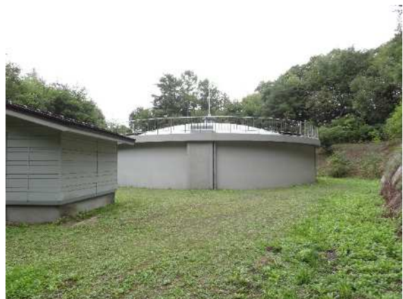
上水道 松崎配水池
