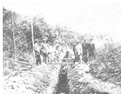
大正13年 居谷里水源と三日町配水池間鉄管埋設工事
