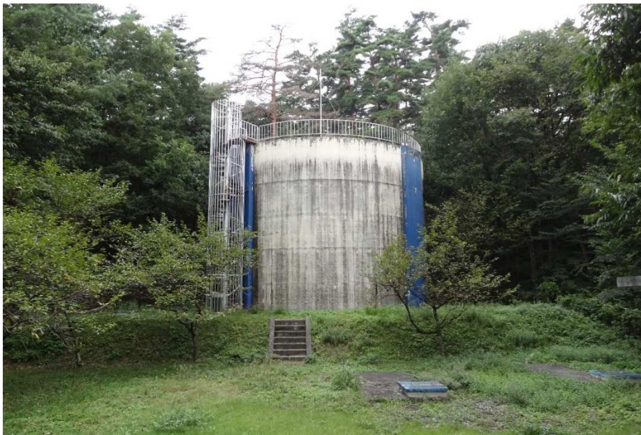
上水道 常盤高区配水池
