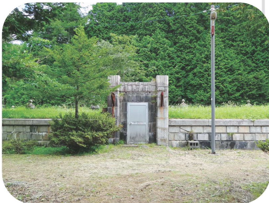
上水道 三日町配水池
