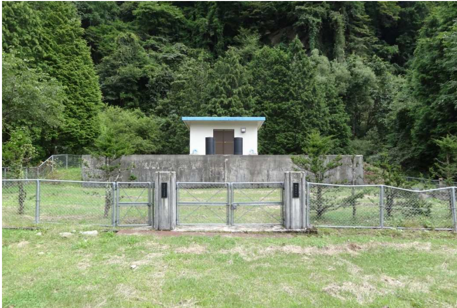
上水道 猫塚配水池
