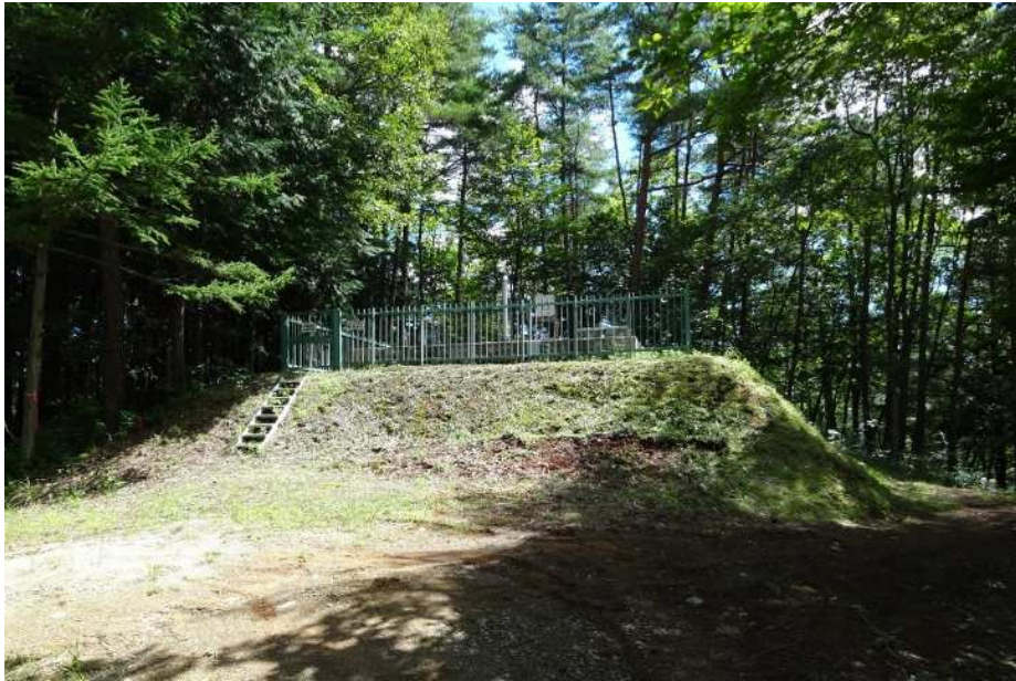
簡易水道 二重高区配水池
