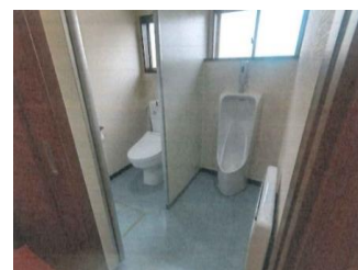
トイレ改修後
