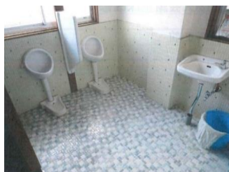
トイレ改修前
