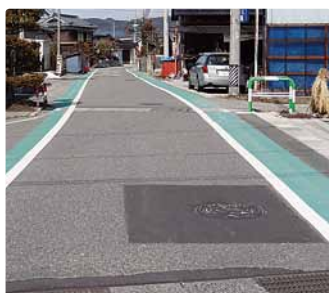
路側帯を広げグリーンベルトを設置した市道（市道北原幸町線）
