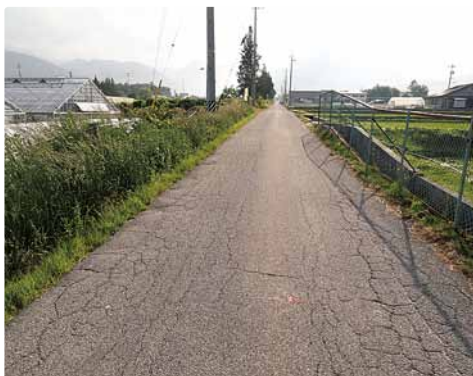
歩道のない市道
