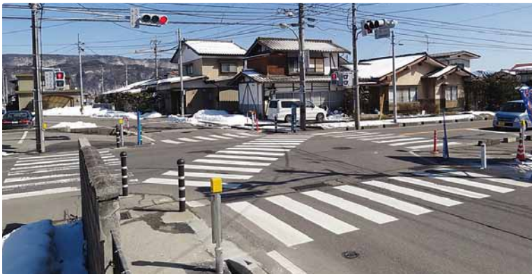
斜め横断が可能となった国道 147 号交差点 (常盤サークルK前スクランブル交差点)
