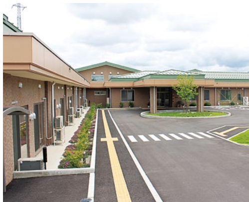
全面改築工事が昨年終了した養護老人ホーム鹿島荘
