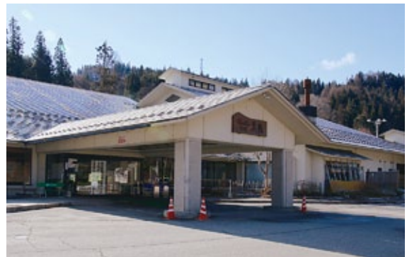
ほかほかランド美麻入浴棟を再建
