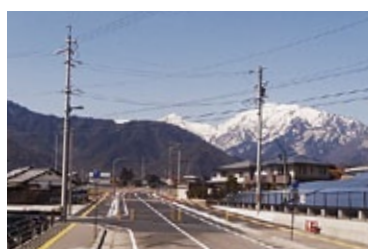
完成後（はなのき保育園側）
