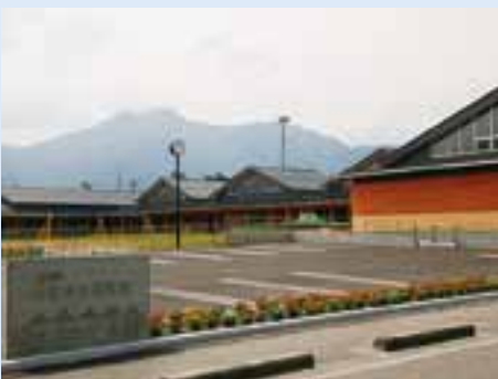
あすなる保育園の一部が完成(写真は完成した園舎) 5億6,481万円
