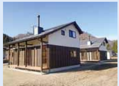
八坂定住促進住宅を野平地区に2棟建設 4,925万円
