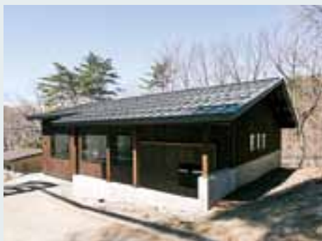
地方創生拠点整備交付金事業としてニホンライチョウ飼育繁殖やライチョウ舎を建設
