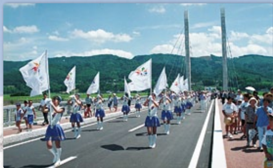
平成6年8月 宮本橋完成
