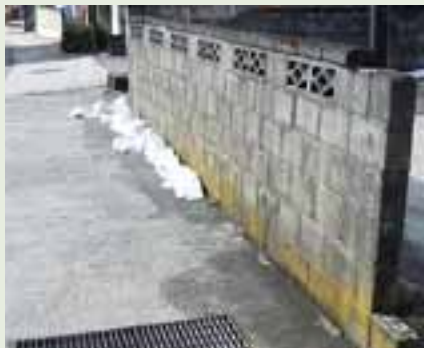
ブロック塀の撤去前
