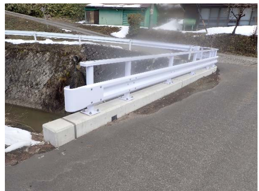
写真6. 高欄補修 万中2号橋 (高欄更新)
