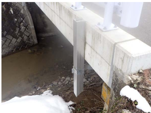
写真5. 排水装置補修 万中2号橋 (排水管更新)
