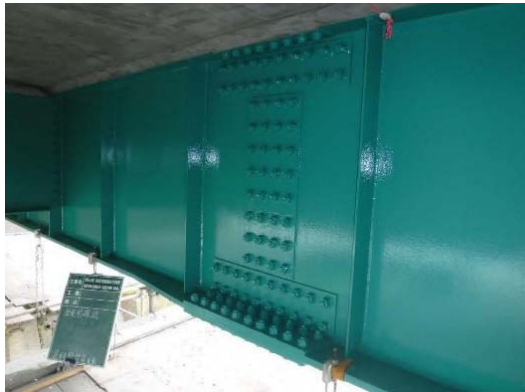
写真3. 主桁補修 満仲橋 (主桁・塗装塗替工)
