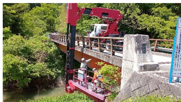
橋梁点検車による点検
