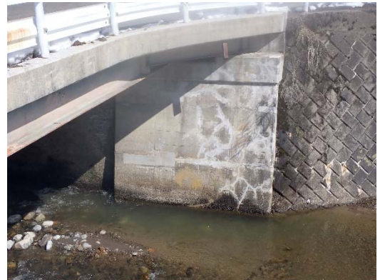
写真4. 下部工補修 万中2号橋 (下部工・ひびわれ充填工)
