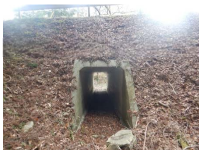
小松尾トンネル
