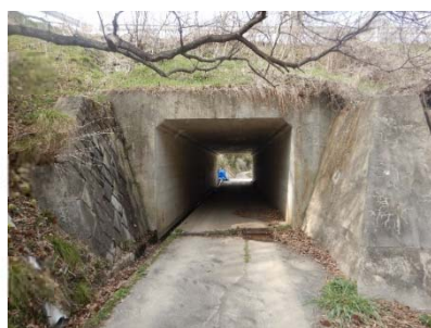
瀬口トンネル
