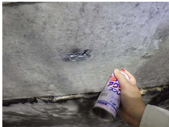
応急処置(防錆処置)状況
