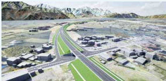
国道147号インターチェンジ付近
