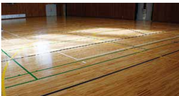
改修が完了した南小体育館の床
