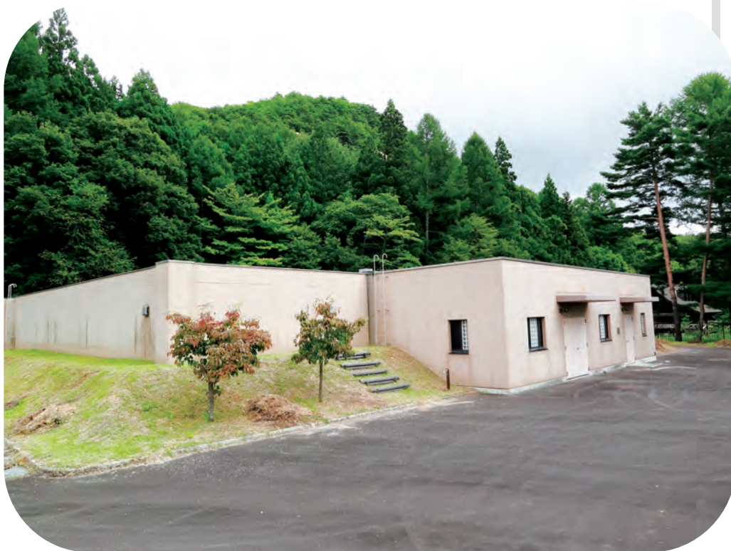
上水道 第3配水池
