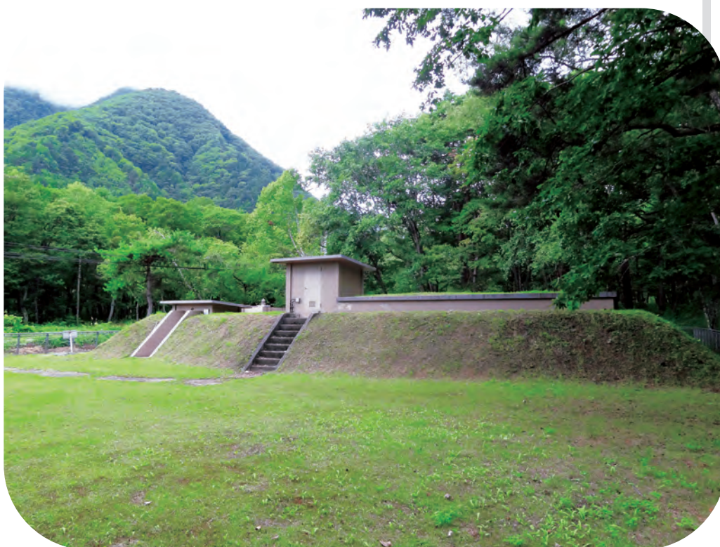
上水道 白沢低区配水池
