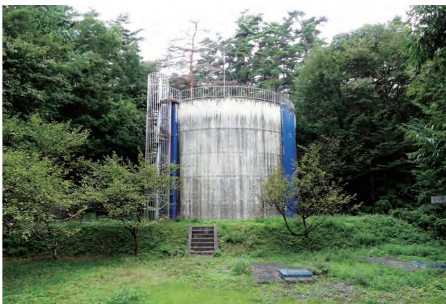
上水道 常盤高区配水池
