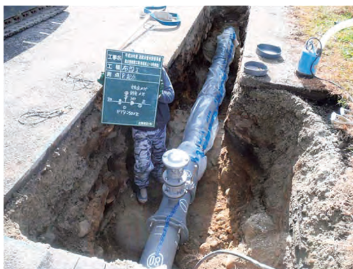
耐震管(ダクタイル鋳鉄管 DCIP-GX 形)
