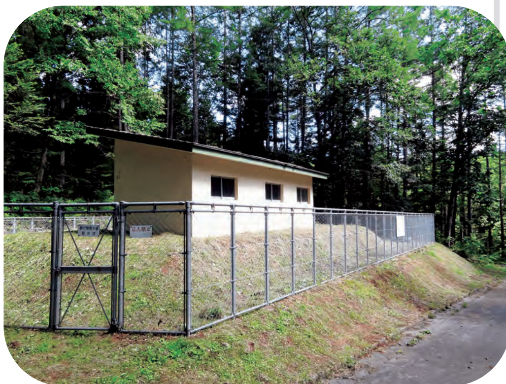
簡易水道 新行配水池
