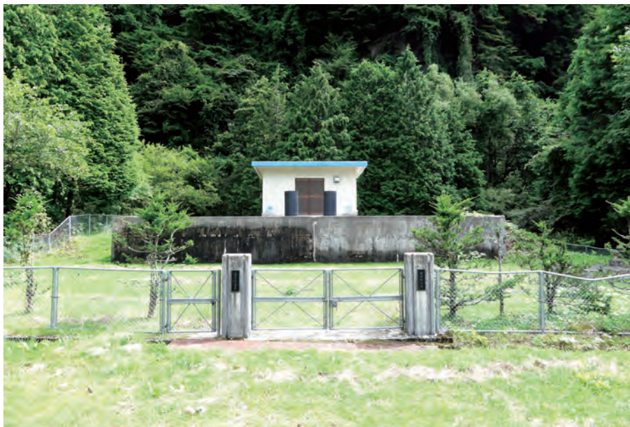
上水道 猫塚配水池
