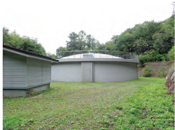
上水道 松崎配水池
