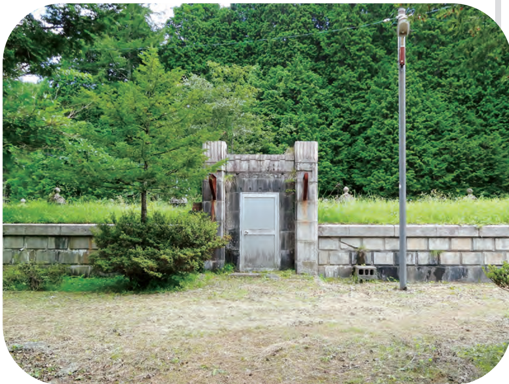
上水道 三日町配水池
