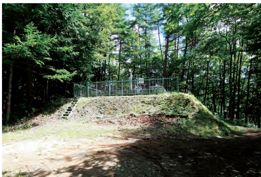
簡易水道 二重高区配水池
