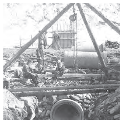
昭和28年 矢沢水源集水管埋設工事
