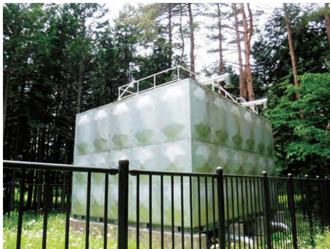
上水道 アルプス接合井(原水供給井)
