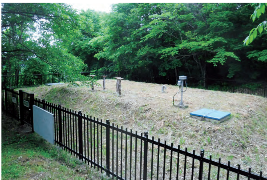
簡易水道 学校上第 2 配水池
