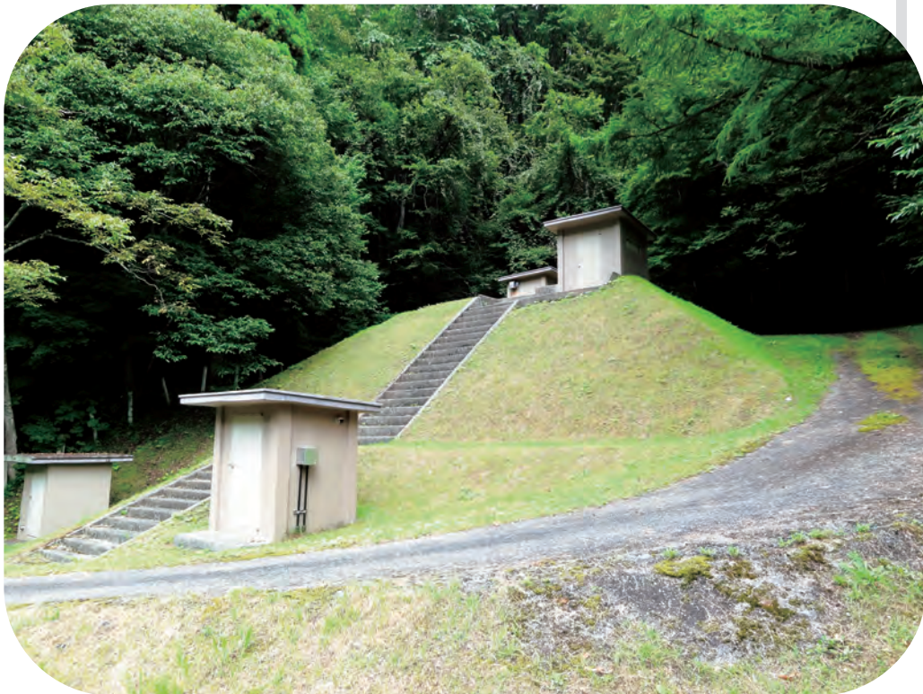
上水道 白沢高区配水池
