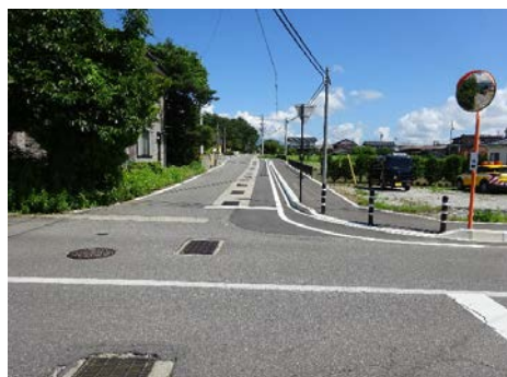
歩道新設：上ー10号線
