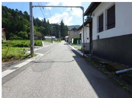
道路改良：神明宮線
