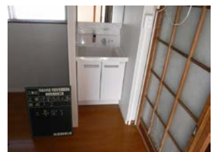
洗面化粧台の設置
