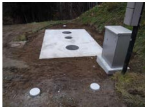
合併浄化槽の設置
