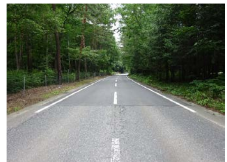
舗装修繕：木崎野口泉線
