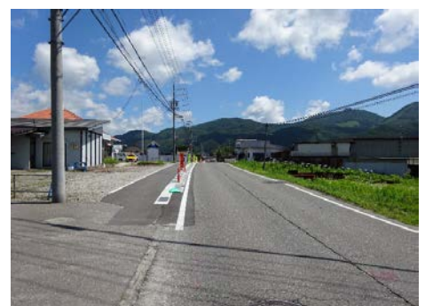
歩道新設：旭町上橋線
