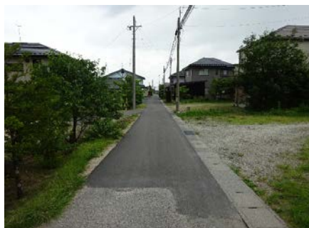
舗装修繕：上一2号線
