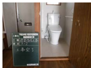
水洗便器の設置
