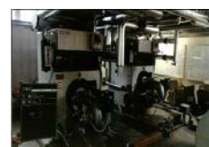
（温水ヒーター更新修繕）
