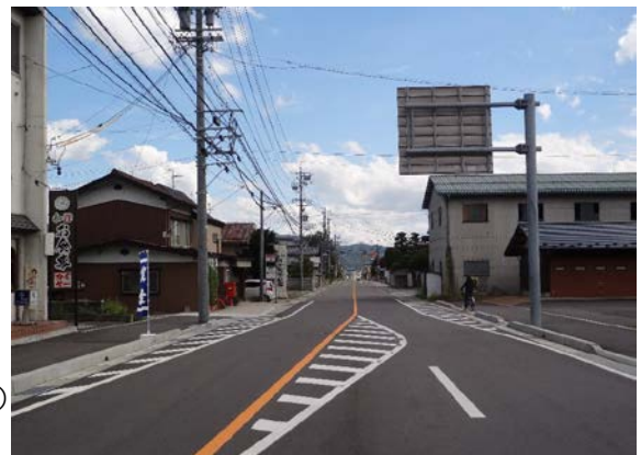
中央通り線（北大町工区：俵町）
