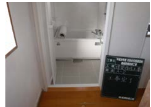
ユニットバスの設置
