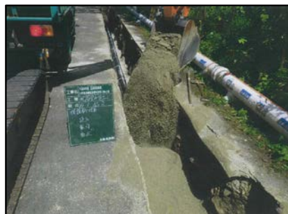
配湯管布設替工事
