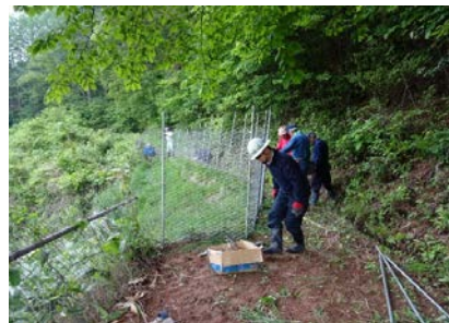
有害獣防護柵修繕作業
