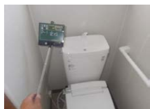
水洗便器の設置
