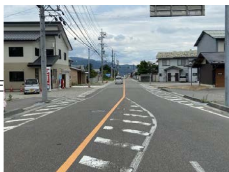
中央通り線（北大町工区）
