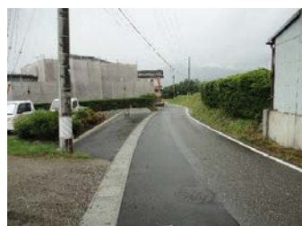
側溝修繕（宮明沢線）
