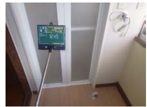
ユニットバスの設置
