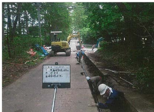
配湯管布設替工事
