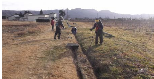
水路工事箇所草刈作業
