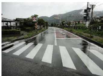
舗装修繕（東町線）
