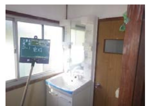
洗面化粧台の設置
