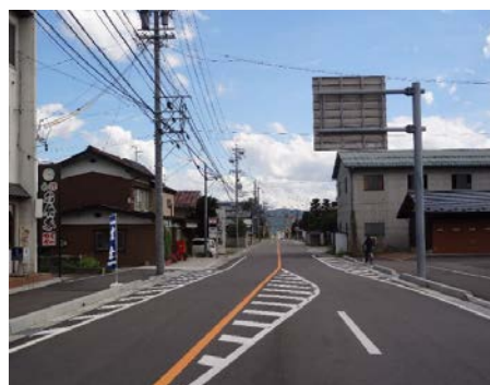
中央通り線（北大町工区）
