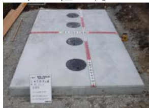
合併浄化槽の設置
