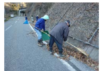
道路愛護事業(側溝清掃作業)
