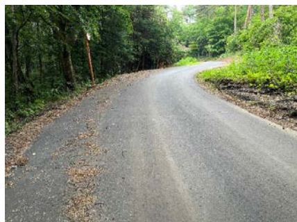
道路改良(相川四辻線)
