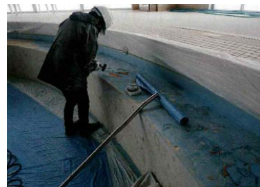
アミューズメントハウスのプールR部塗装
