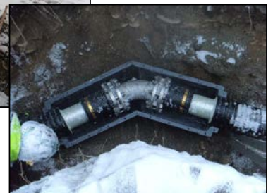
配湯管布設替工事
