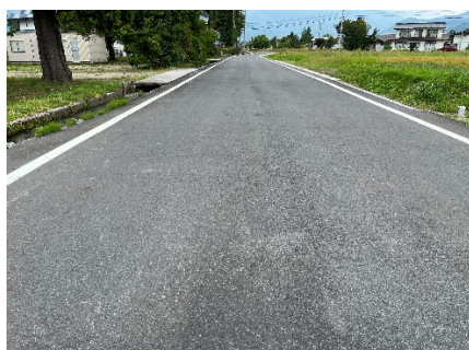
道路改良(野口15号線)
