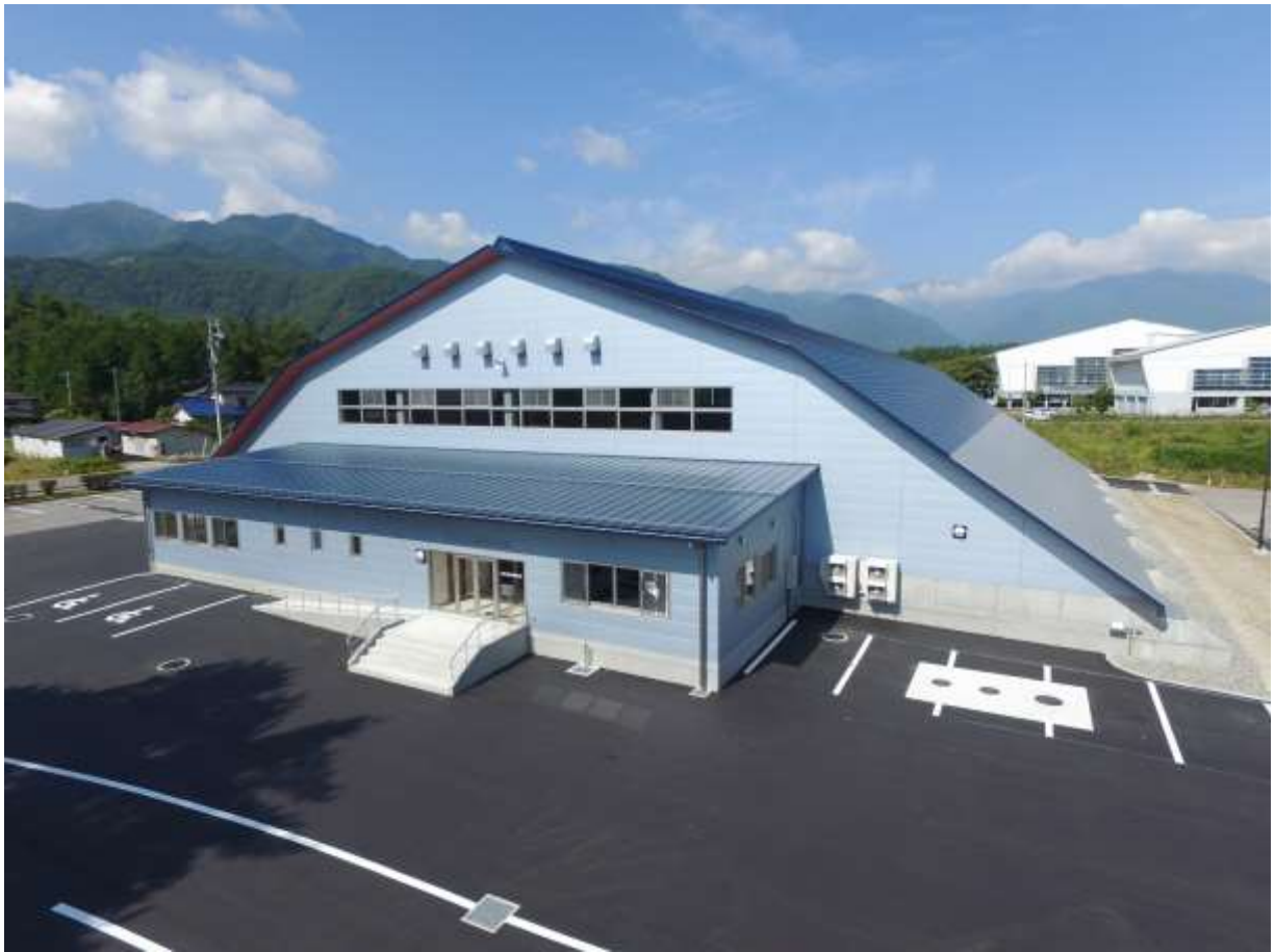
第二屋内運動場（平成 29 年 9 月 29 日竣工）
